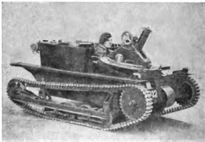
Рис. 36. Установка миномета на танкетке Карден-Лойд (Англия).
